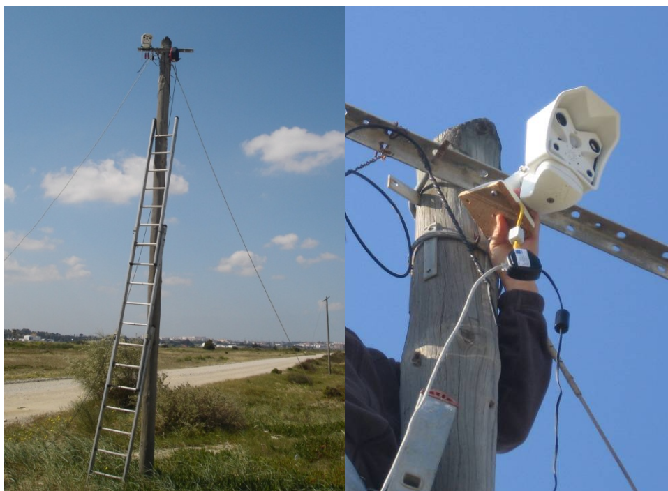
Figura IV. 5- Instalação da câmara de vídeo obliquamente à praia, num local elevado.
